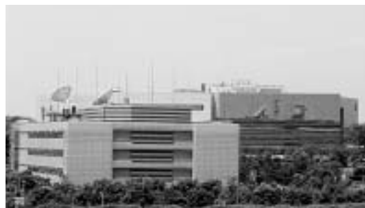
サービスを提供する為のサーバー機器群がおかれる横浜コンピュータセンター
