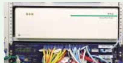
新宿オフィス内に設置されたシステム(上:MX250、下:バッテリーシステムとPoEスイッチ)
