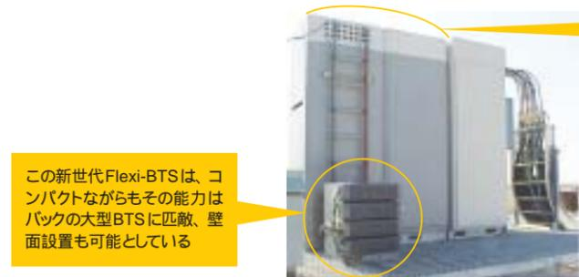
この新世代Flexi-BTSは、コンパクトながらもその能力はバックの大型BTSに匹敵、壁面設置も可能としている
