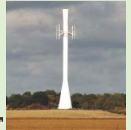
▶ユニークな外観をもつTower Tube基地局 中央のプロペラは風力発電用
